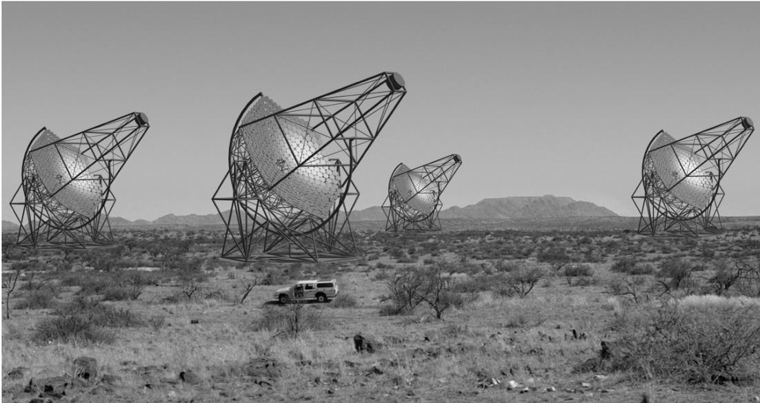
**Abbildung 9.1:** Fotomontage der ersten Ausbauphase des H.E.S.S.-Observatoriums mit 4 Teleskopen im Khomas-Hochland auf einer Höhe von 1800 m über Meeresniveau in Namibia. Die 4 Teleskope mit einem jeweiligen Durchmesser von 11 m haben eine um das zehnfache gegenüber den HEGRA-Teleskopen vergrößerte Lichtsammel­fläche. Die Nachweisschwelle sinkt entsprechend auf 50 GeV. In der zweiten Ausbauphase sind 16 Teleskope auf einer vergrößerten Grundfläche geplant.
